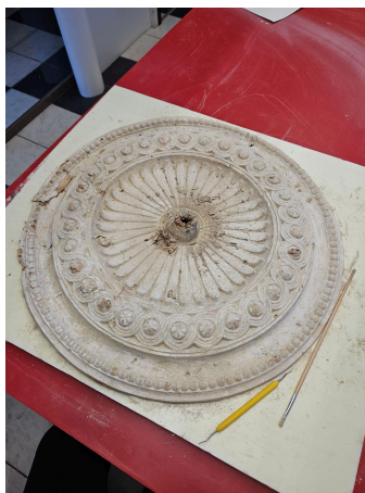
Joonis 11. Roseti kuivpuhastuse protsess.
