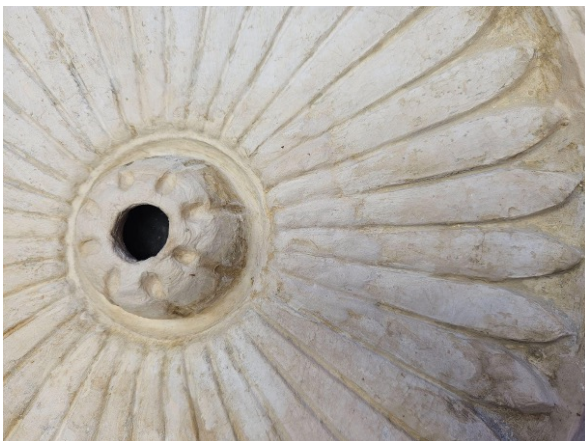
Joonis 33. Roseti kese peale modelleerimist
