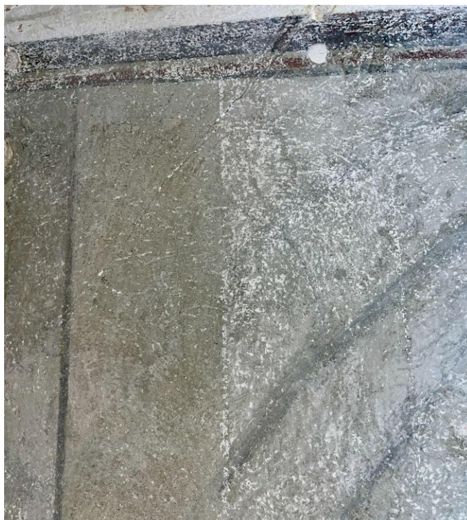
Foto 2.12. Detailpuhastus vasakul fiiberklaasist puhastuspliatsiga.
