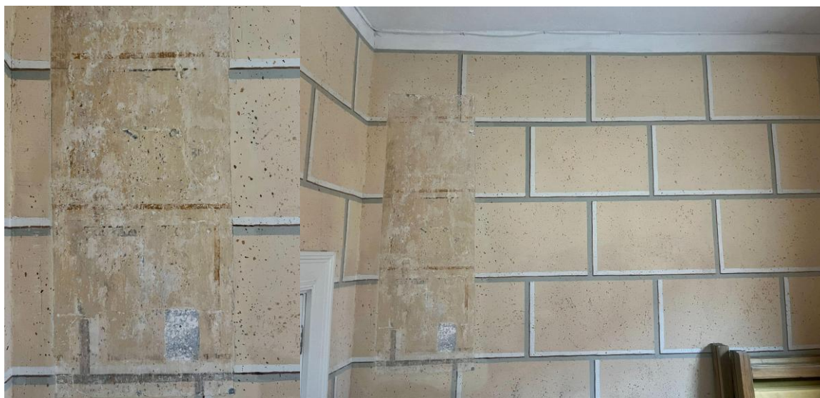
Foto 1.10. Lutsu 8 kvaadermaalingu sondaažiava näitab mitme kvaadri kihistusi.
