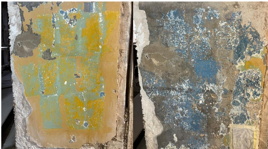
Foto 7. Atsetooni ja Evolon kangaga tehtud kompresside pehmendav mõju võimaldas värvi eemaldada skalpelliga.
