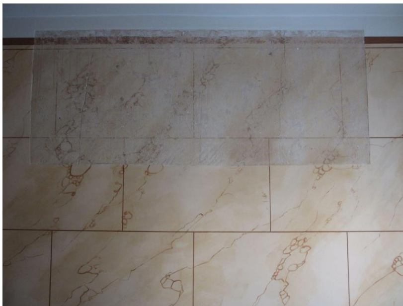
Foto 1.14. Veski 55 kvaadermaalingu sondaažiava ja rekonstruktsioon. Autor: Kristiina Ribelus
