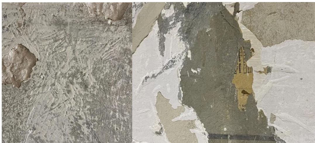
Foto 2.10. Valge liimvärvi eemaldamine skalpelliga.
