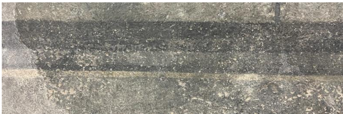
Foto 1.20. Paneeliosa kohal olevad ehisjooned.
