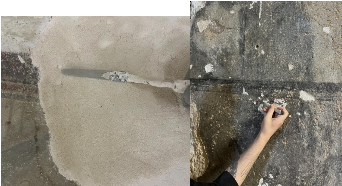
Foto 11. Krohviparanduse silumine spaatliga
