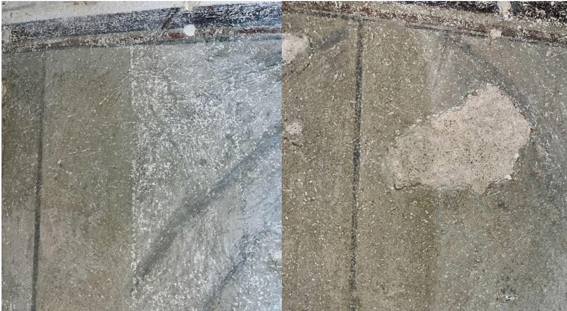
Foto 9. Fiiberklaasist puhastuspliatsiga puhastatud pind vasakul (vasak foto).
