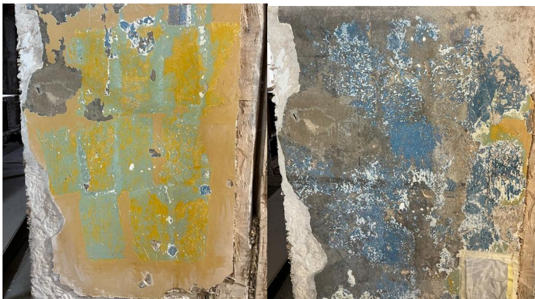
Foto 2.7. Kompressi ja atsetooniga eemaldatud õlivärvi alad.
