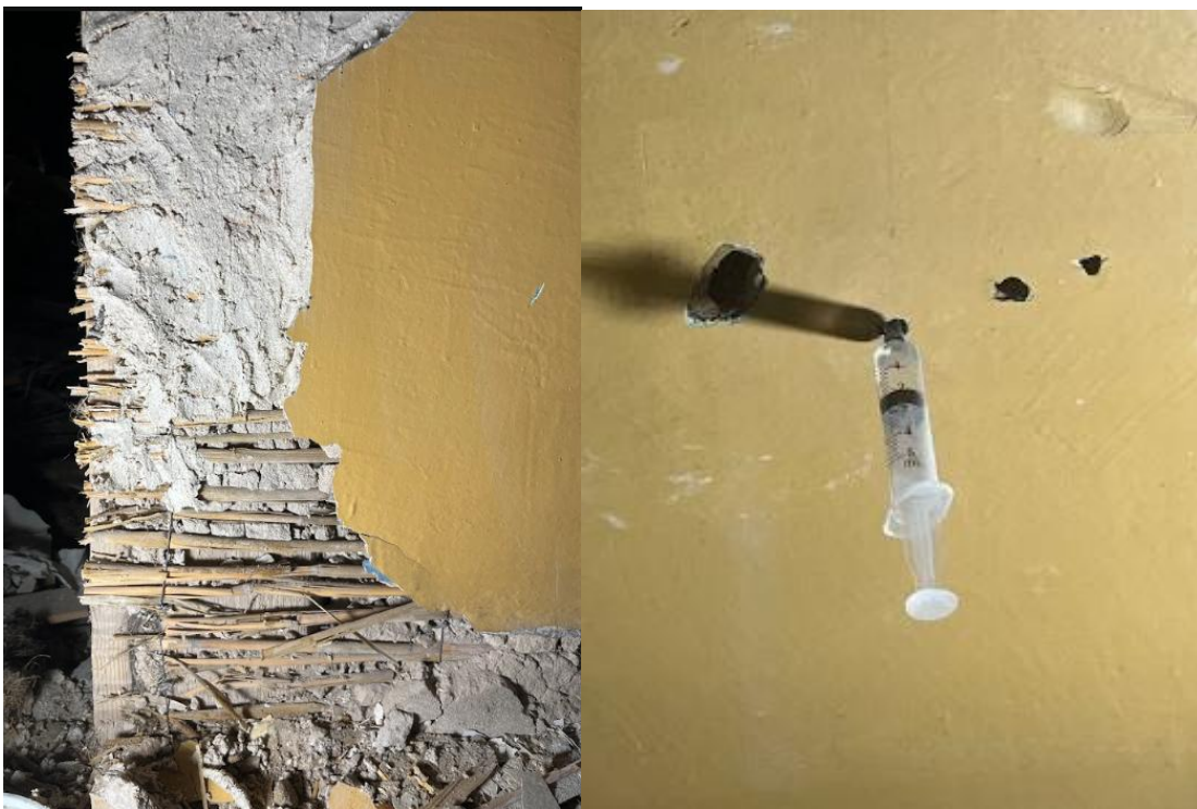
Foto 3. Lubikrohvi sisseviskekiht roomatil.
