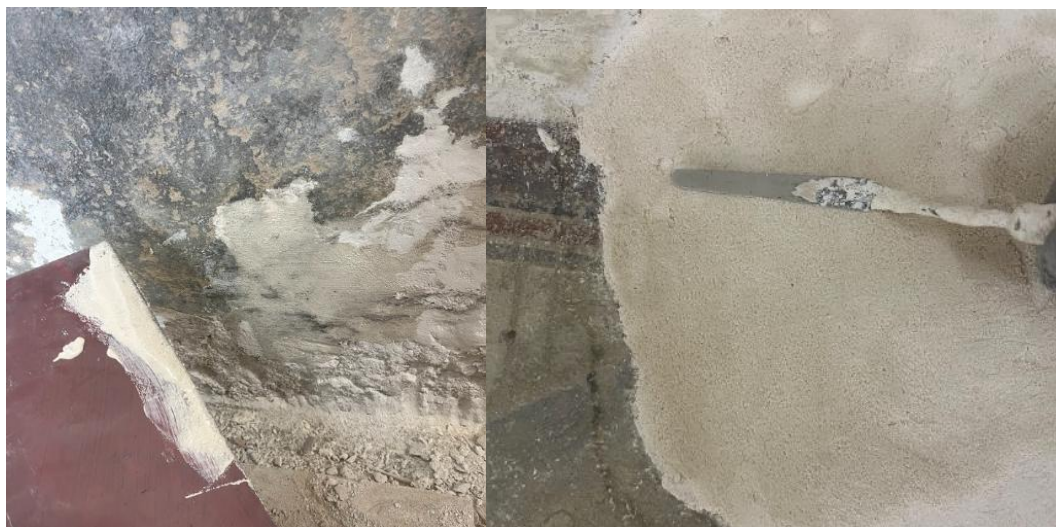
Foto 2.14. Krohvikihhi silumine suuremal pinnal sirge servaga.
