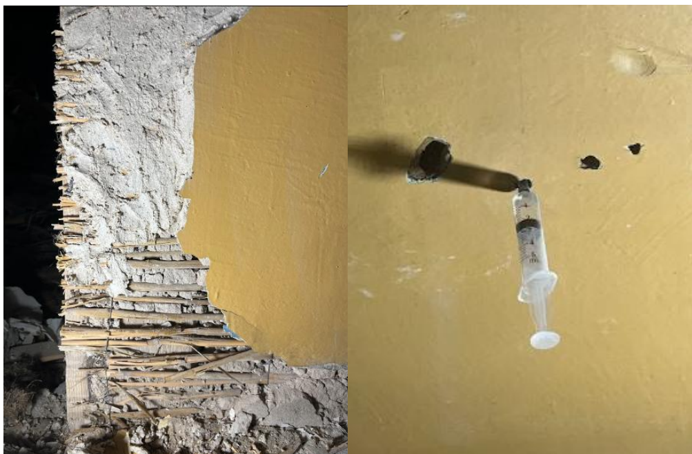
Foto 2.4. Lubikrohvi sisseviskekiht roomati peal.
