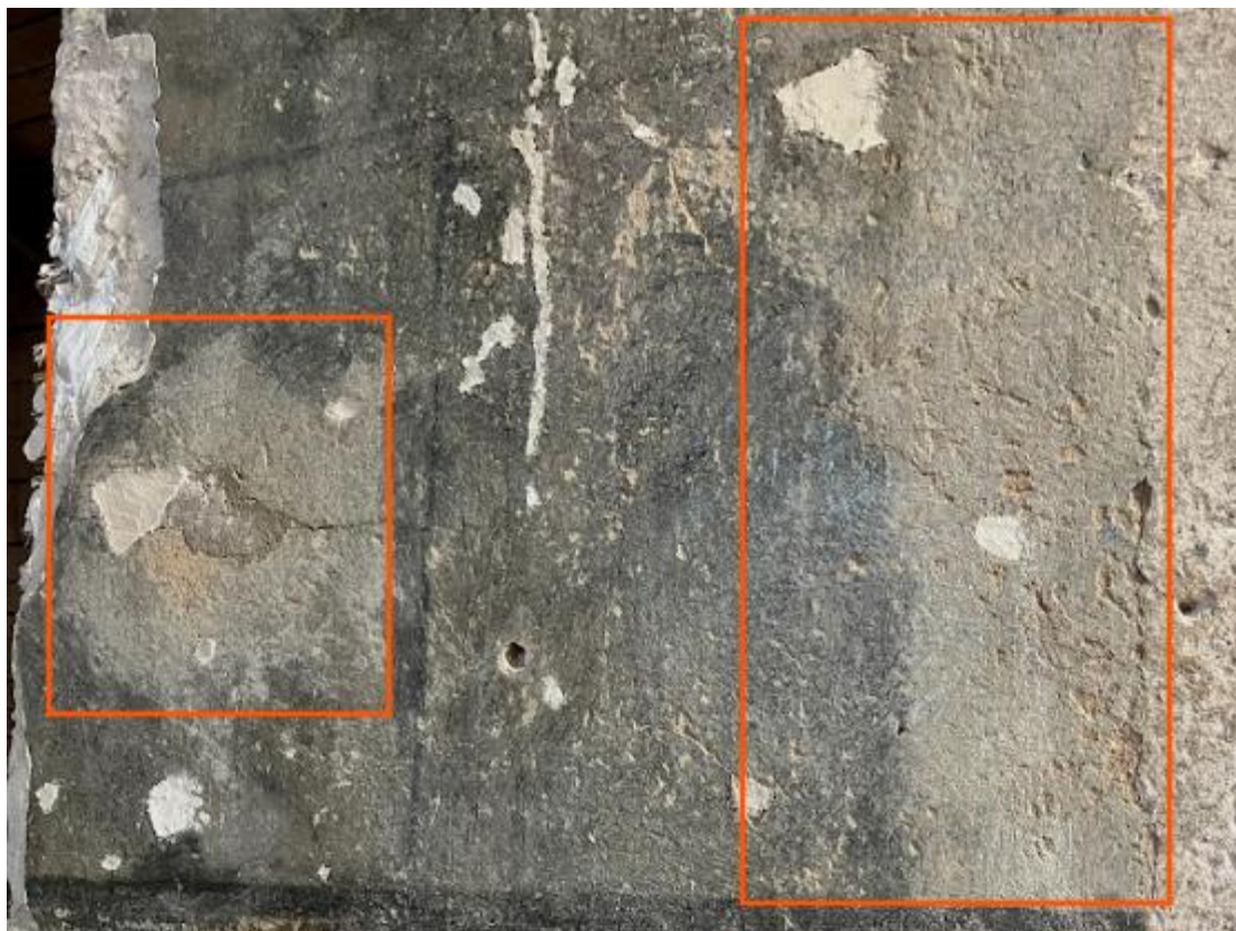
Foto 2.9. Märgitud alad on olnud krohvitud enne õlivärvi kihti, mistõttu need ei ole diskoloreerunud.
