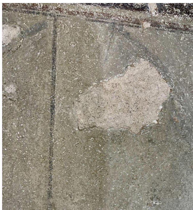
Foto 2.13. Akapad käsnaga puhastus (vasakul) pärast detailpuhastust (paremal).
