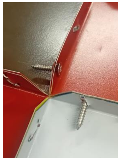
Joonis 7. Kruviga tugevdatud ühendus
