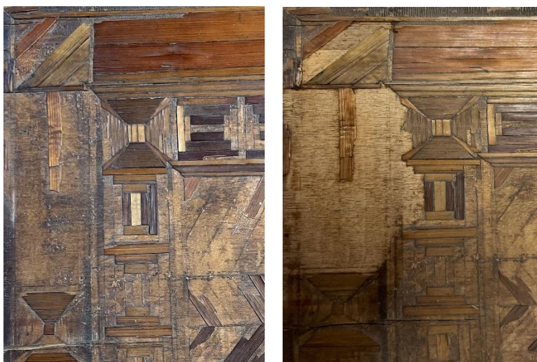
Foto 15 Pind enne puhastamist Foto 16 Pind pärast puhastamist.
