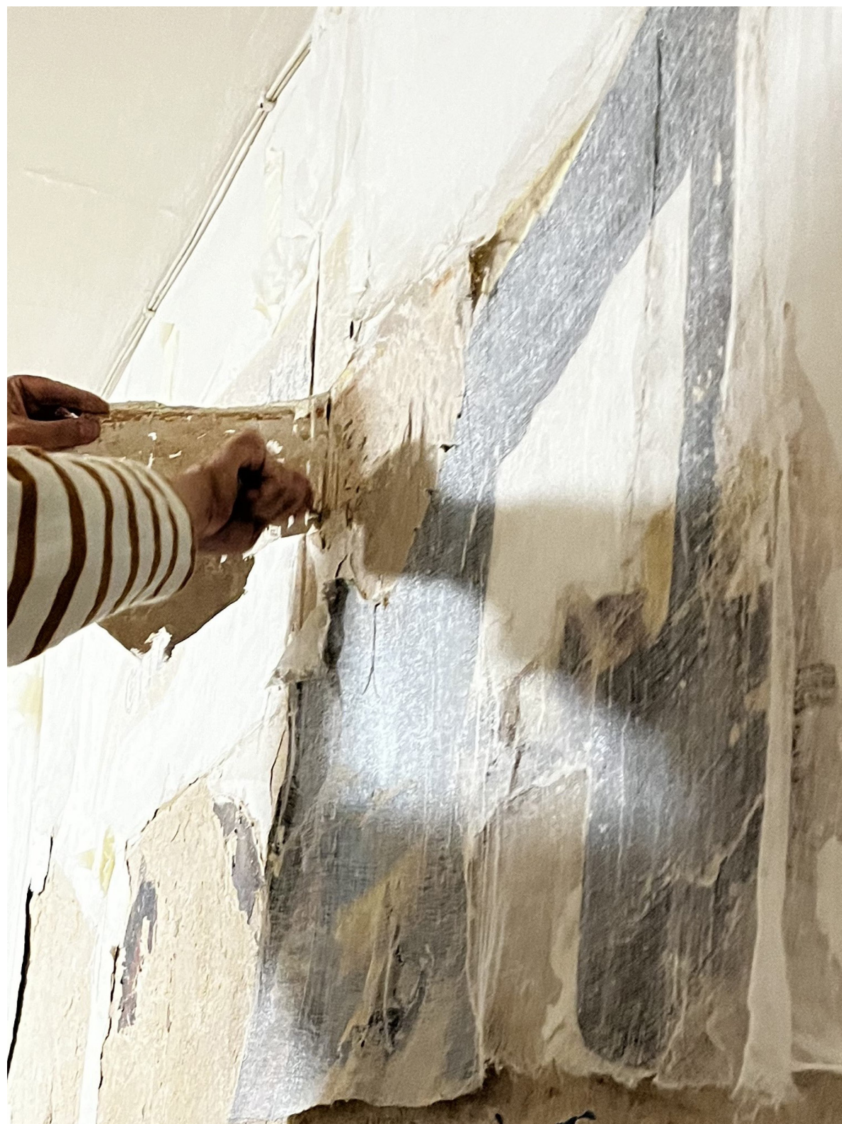
Seinamaalingu eemaldamine keldri seinast. Foto: erakogu.
