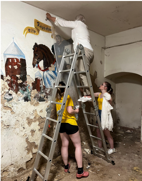
Joonis 6. Seinamaalingule profülaktilise kanga paigaldamine. Foto: erakogu. Joonis 7. Seinamaalingule profülaktilise kanga liimimine. Foto: Kristel Kajak.
