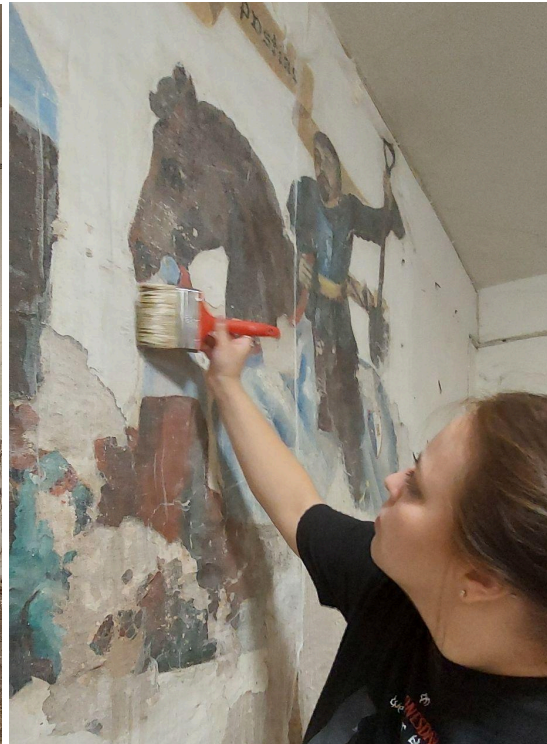
Joonis 6. Seinamaalingule profülaktilise kanga paigaldamine. Foto: erakogu. Joonis 7. Seinamaalingule profülaktilise kanga liimimine. Foto: Kristel Kajak.
