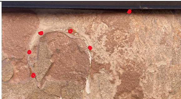
Pilt 6. Jaapani paberiga tugevdatud maaling, mille ümbruses tehti mitmeid injekteerimisi, mis on tähistatud punase täpiga.
