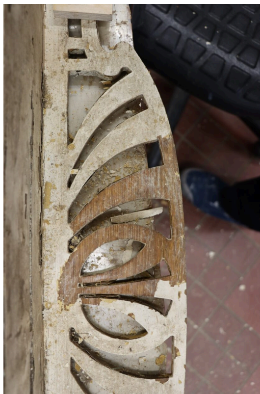
Foto 7. Hilisema viimistluse eemaldamine konstruktsioonilt. Foto 8. Hilisema viimistluse eemaldamine lõigetelt.
