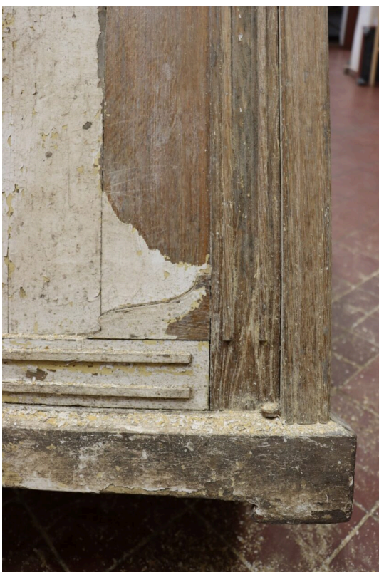
Foto 7. Hilisema viimistluse eemaldamine konstruktsioonilt. Foto 8. Hilisema viimistluse eemaldamine lõigetelt.
