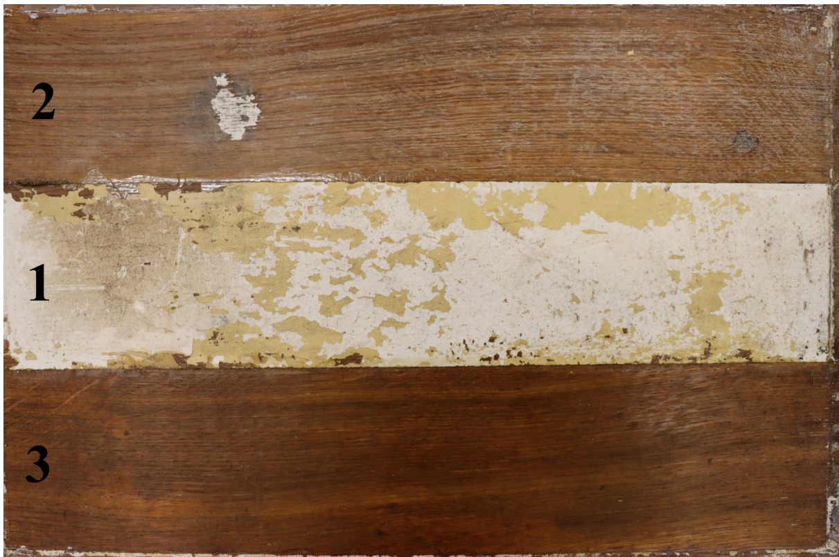
Joonis 4. 1 - pind enne üle värvimiste eemaldamist; 2 - pind peale viimistluskihi mehaanilist eemaldamist; 3 - pind pärast lakibensiini ja karukeelega puhastamist. (Autori foto)
