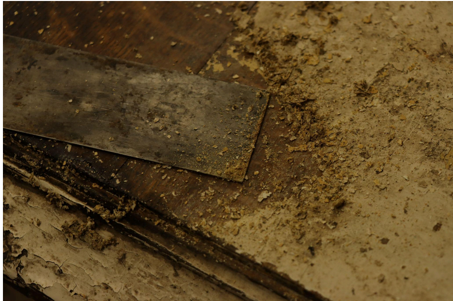
Foto 8. Viimistluse eemaldamine lakibensiini kompressiga ning kaaplehega tasapinna parempoolselt nurgalt (Autori foto)
