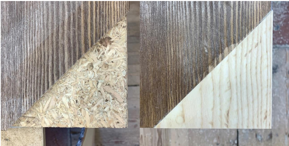
Joonis 3.3 Kahjustus nr 4 enne ja pärast parandusmaterjali liimimist. Autori foto
