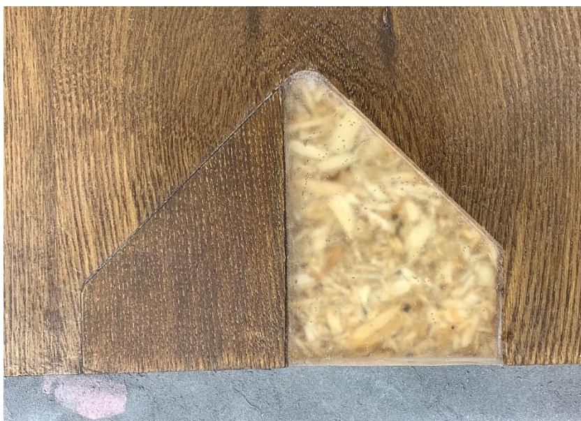
Joonis 3.12 Kahjustus nr 5 peale spooniparandust ning peitsimist. Autori foto
