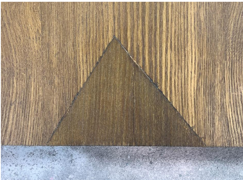
Joonis 3.6 Kahjustus nr 2 peale spooniparandust ning peitsimist. Autori foto
