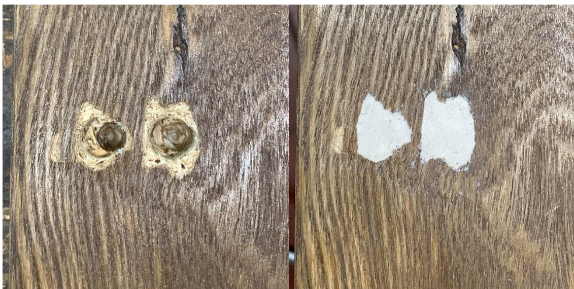
Joonis 3.7 Kahjustus nr 3 enne ja pärast epoksükitiga täitmist. Autori foto.
