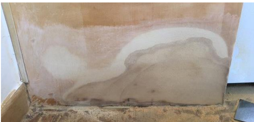
Joonis 1.12. Soolad MDF plaadi pinnal. (Need to... 2021)
