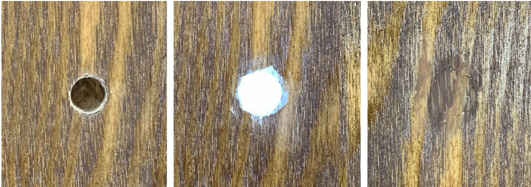
Joonis 3.13 Tüübli auk enne pahteldamist, peale pahteldamist ning peale retušeerimist. Autori foto
