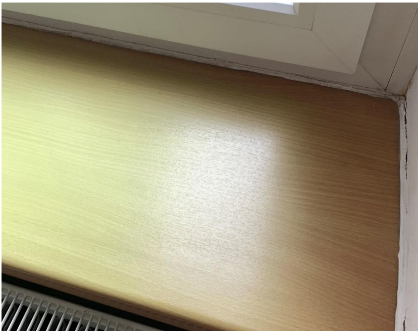
Joonis 1.10. Melamiinplaadi värv on muutunud UV mõjul rohekaks. Autori foto.
