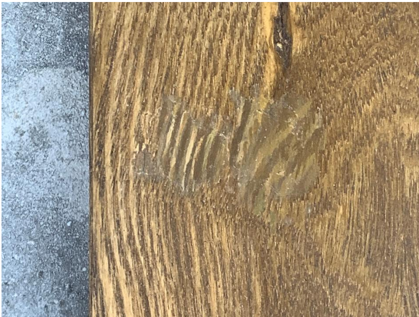
Joonis 3.8 Epoksükitt peale retušeerimist. Autori foto
