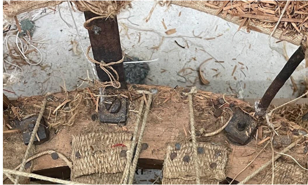
Foto 14. Konstruksiooni kinnitus raamile
