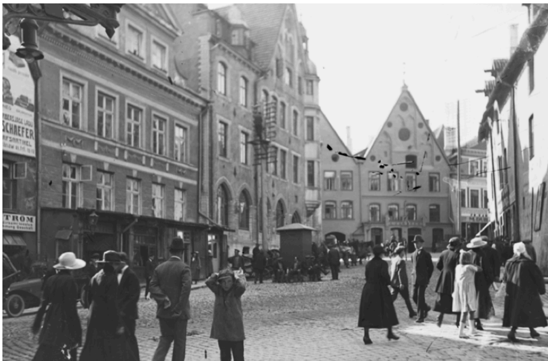
Joonis 5. Raudkiosk alajaam Vanaturul, vaadeldavad on nii õhuliinid kui elektri tänavavalgusti, foto: elektrilevi.ee
