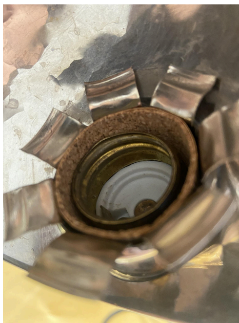
Joonis 4. Asendatud isolatsioon, kahekordsest naturaalsest korgist, lähemalt näha puhastatud metallpinda
