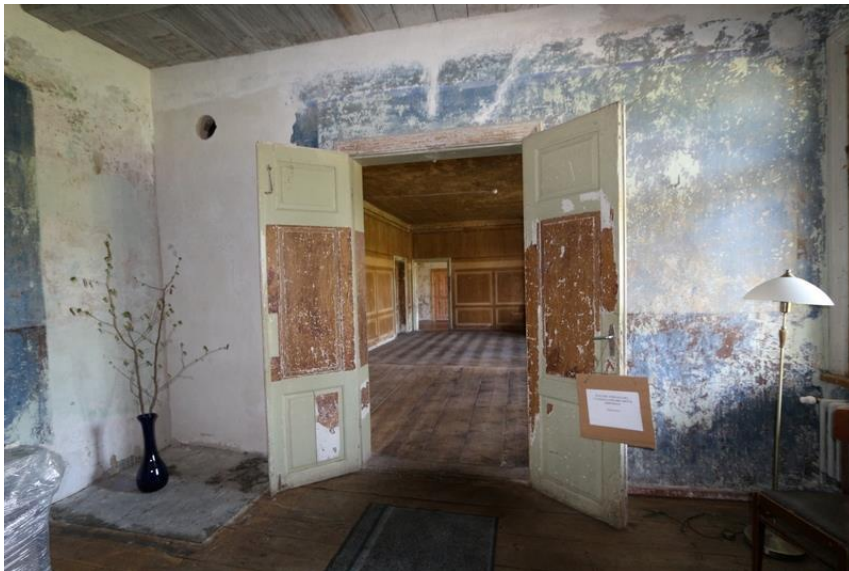
Foto 16. Vaade söögituppa. (M. Toom)
