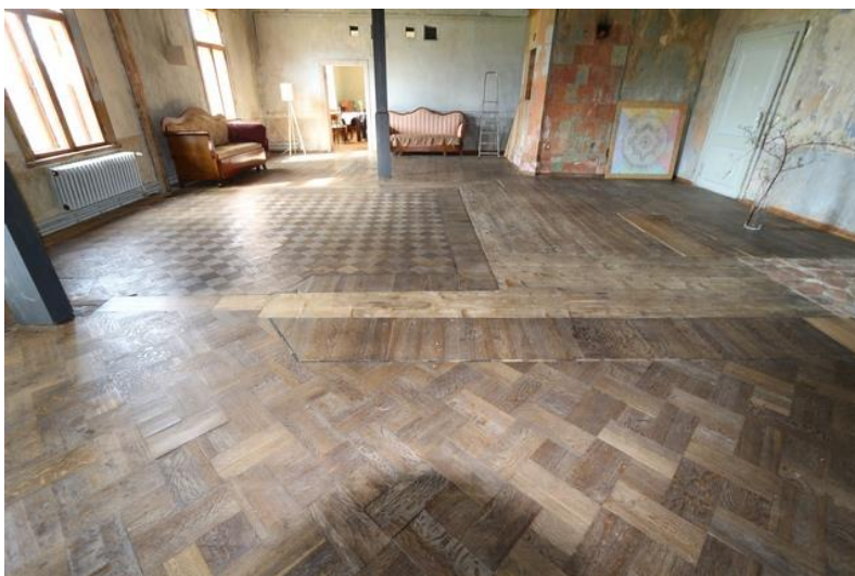
Foto 49. Avatud saali vaade. Põrand järgib varasemat ruumijaotust. (H. Tuksam)
