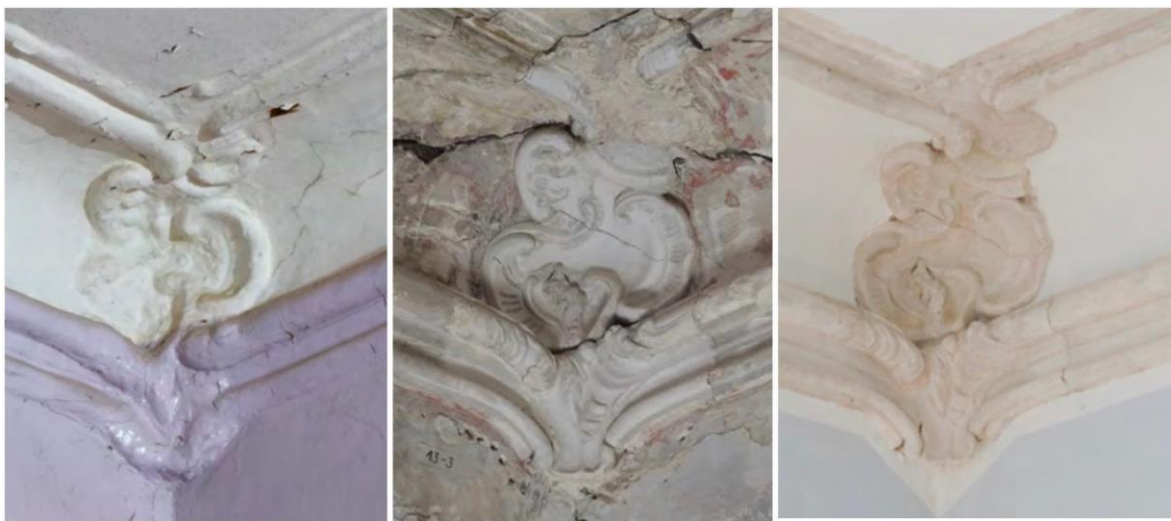
Joonis 2 Purdi mõisa nurgastukk enne avamist (vasakul), peale hilisemate värvikihtide eemaldamist ja paremal nurgastukk avamise ja viimistlemise järgselt. Foto: Eesti Kunstiakadeemia (Hiio jt 2019)
