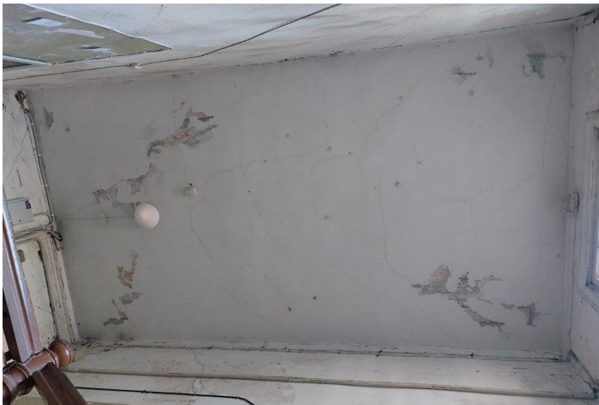
Pilt 11. Vabriku 2 trepikoja laemaaling enne tööde algust
