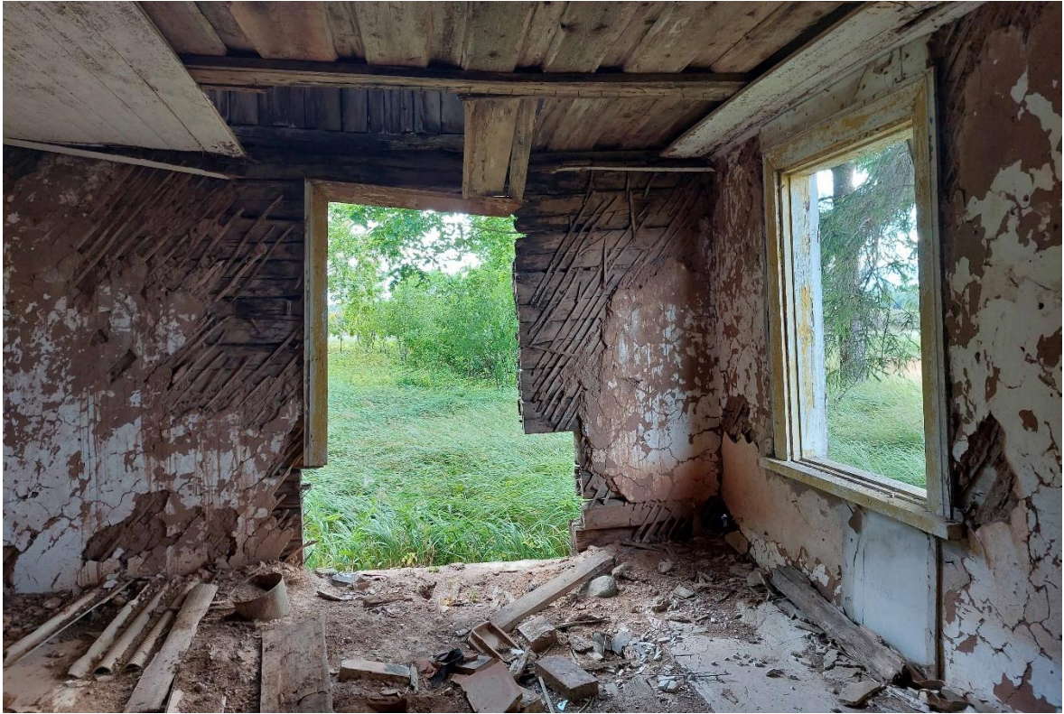
Pilt 151. Pargi talu elumaja interjäär. Seintel on kasutatud savikrohvi
