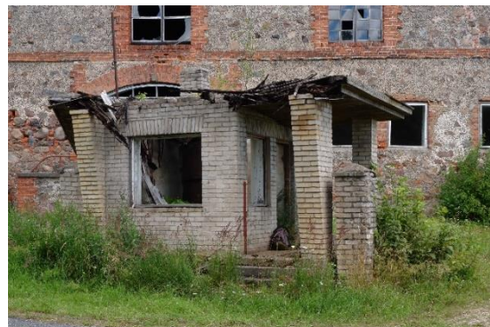
Pilt 254. Valvuriputka Meleski klaasivabriku ees
