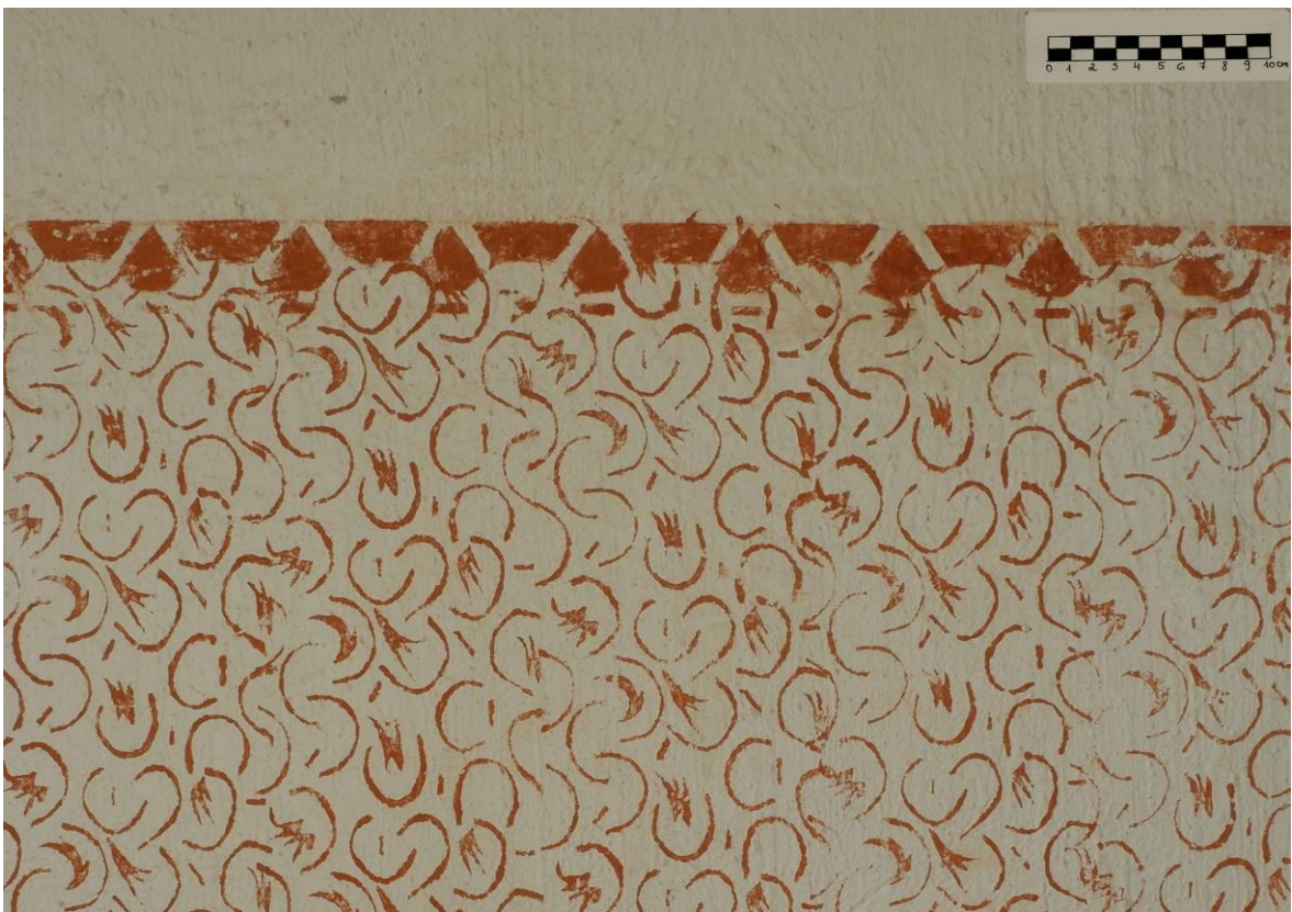
Pilt 110. Hüdroelektriijaama seinu kattev rullmuster ja seda ülalt piirav trafarettmuster. Otsevaade
