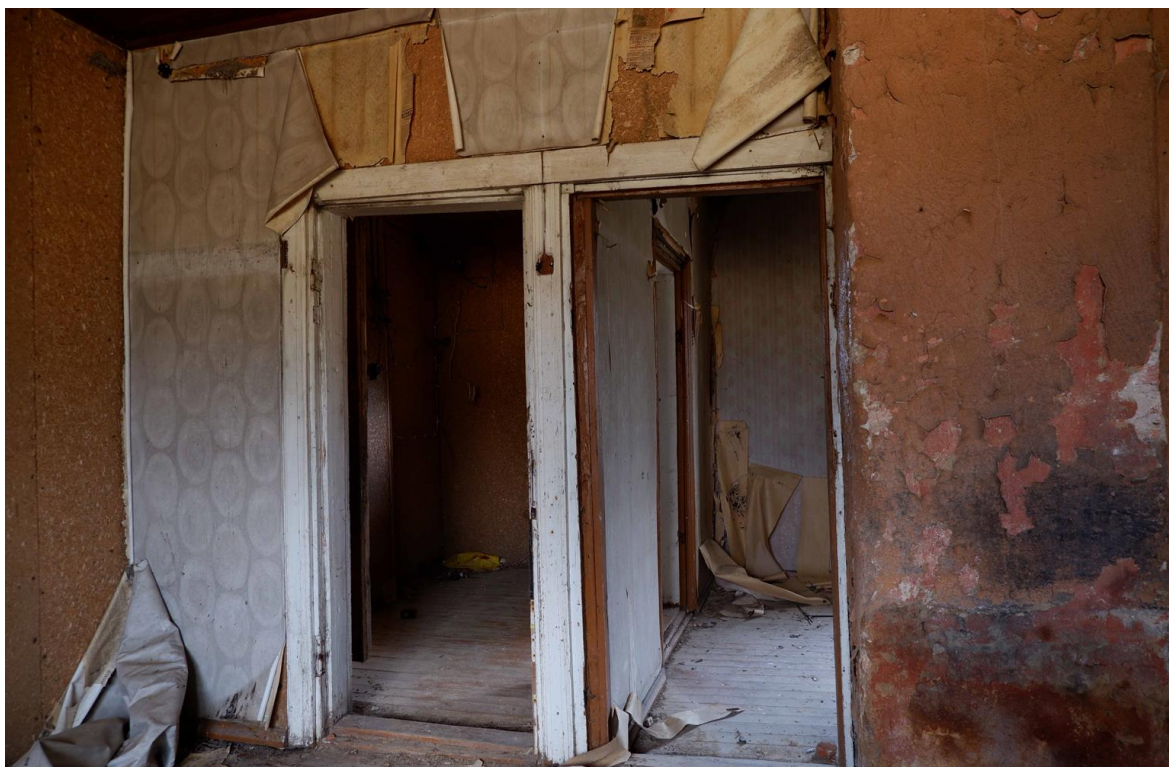
Pilt 177. Kasemetsa talu elutuba
