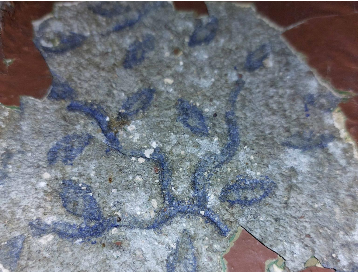
Pilt 125. Sama rullmuster lähemalt, mustrirull on krohvi pinnale mustri sisse vajutanud. Foto: Melissa Tihhonova
