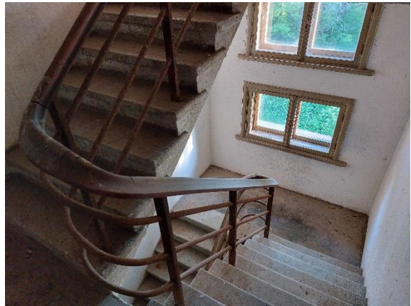
Pilt 232. Paekivist astmetega trepp
