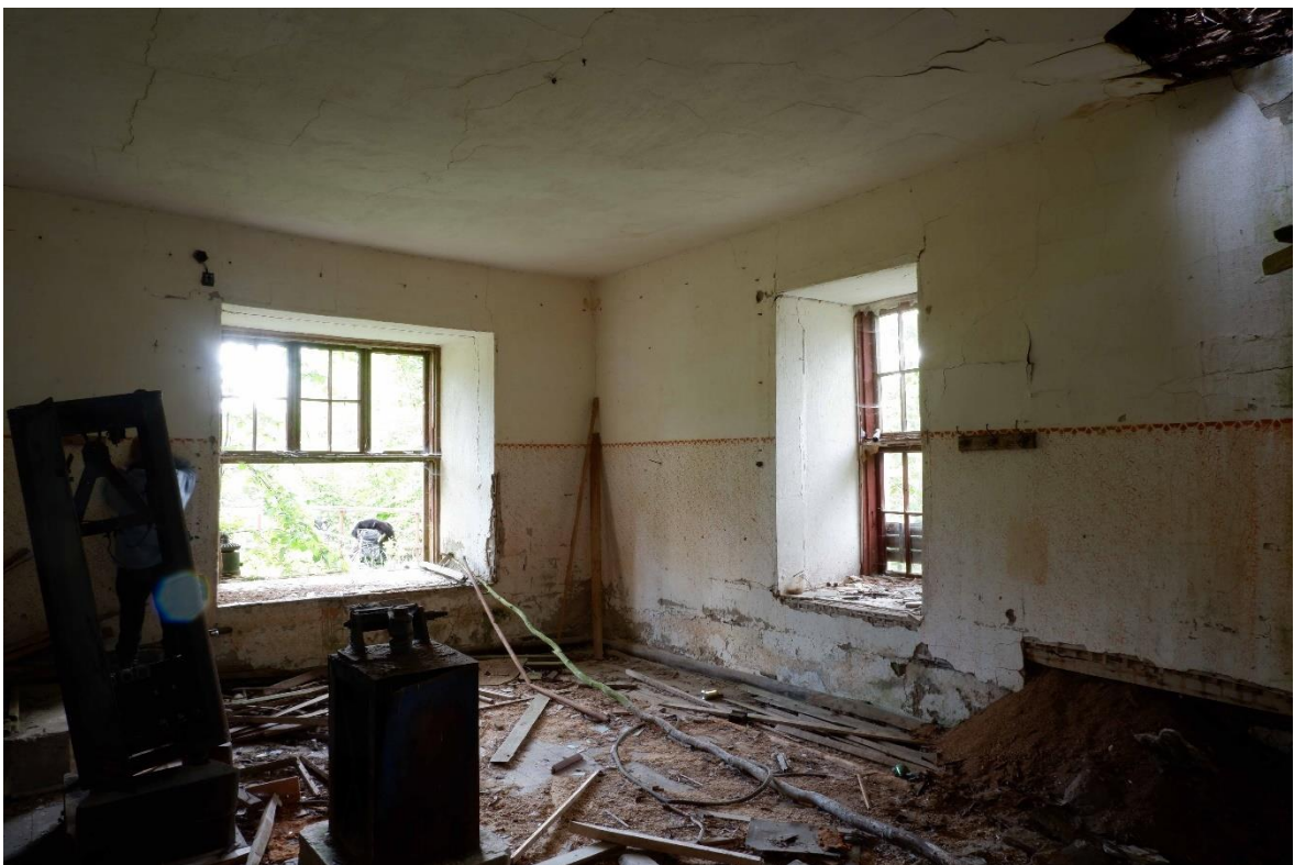
Pilt 109. Elektrijaama pearuum koos paljaks varastatud seadmetega
