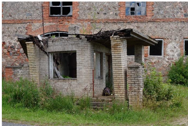
Pilt 254. Valvuriputka Meleski klaasivabriku ees
