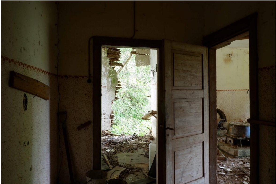
Pilt 108. Keskmine ruum Rimmu hüdroelektrijaamas
