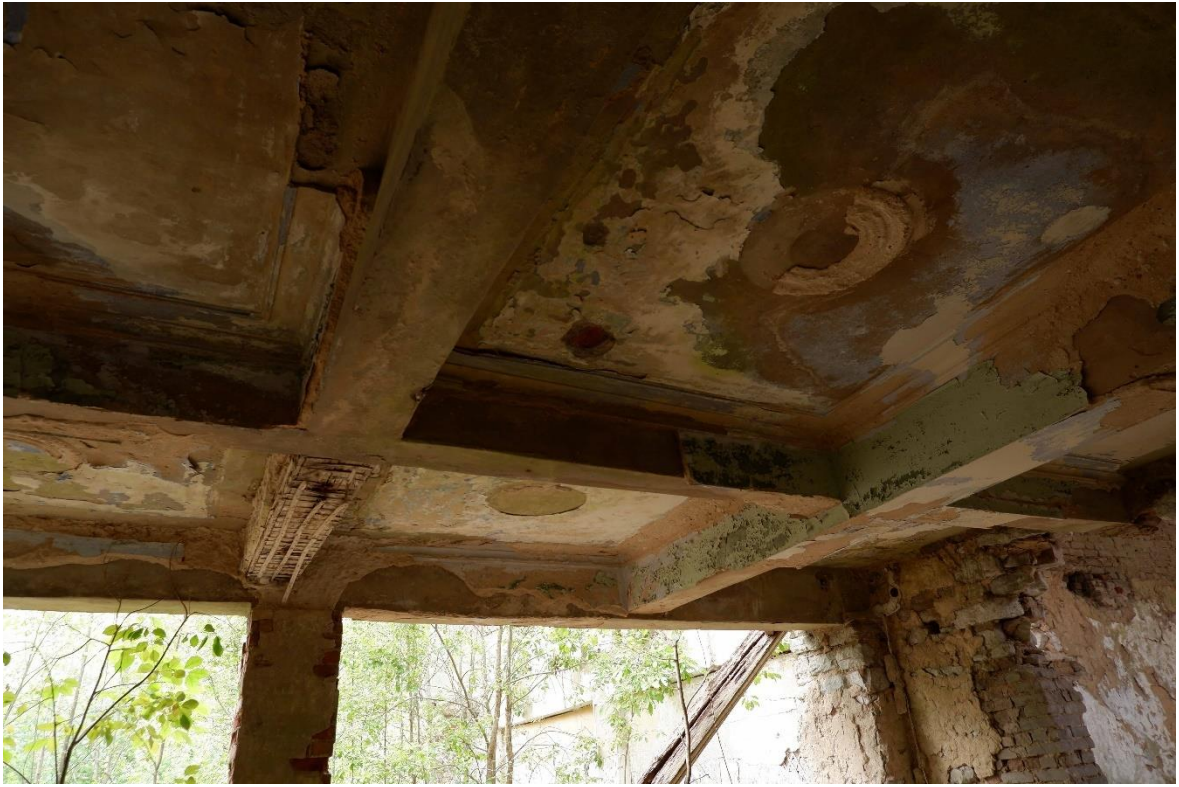
Pilt 47. Massiivne kassettlagi Viivikonna kaevanduse peahoones
