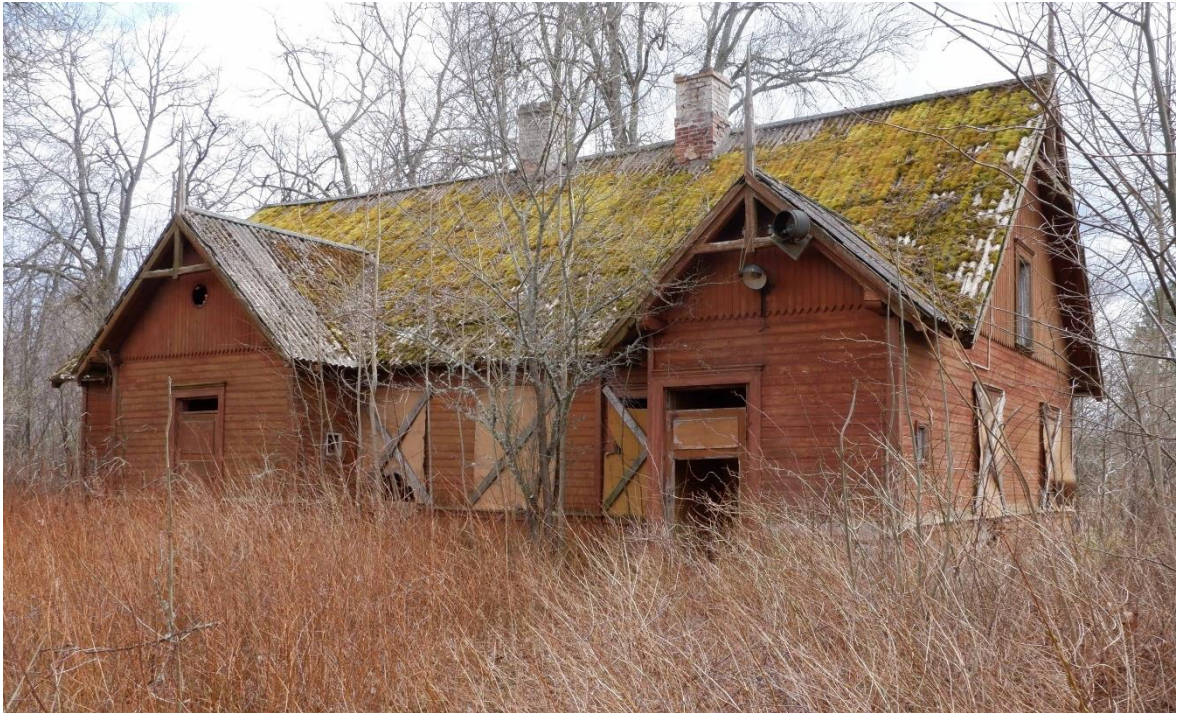
Pilt 16. Järve-Saprani talu eluhoone järvepoolne fassaad
