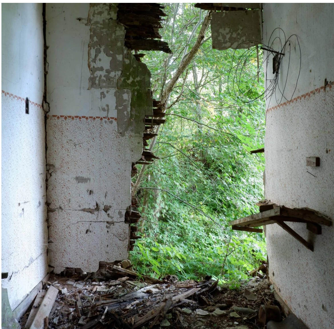
Pilt 105. Läbi mädanenud seiniosa Rimmu elektrijaamas
