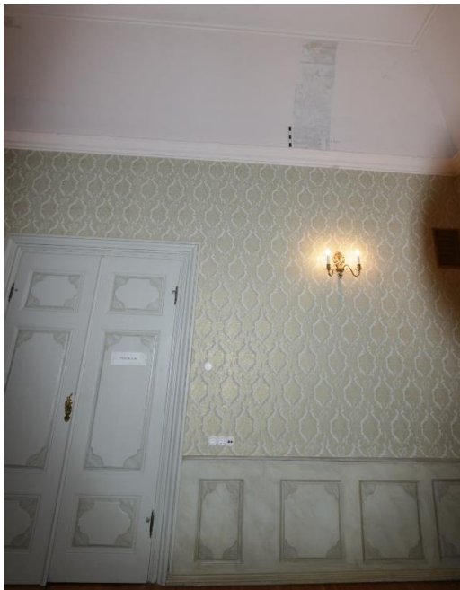
Foto: Sondaž peegelvõlvil. Teostati 2012.
