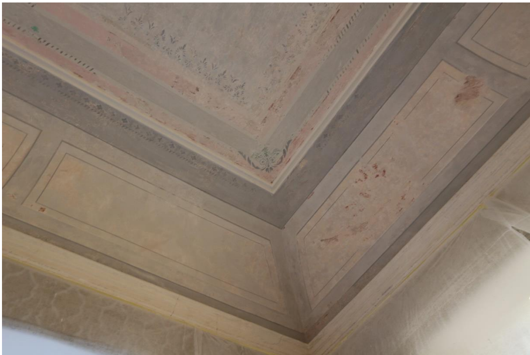
Foto Lae kagunurga viimistlus. Laes ornamendiribad roosast ja hallist kihistusest. Tahveldisel draperii esimesest kihistuses, punae ornament roosast kihistusest. Tahveldis hallist kihistusest.
