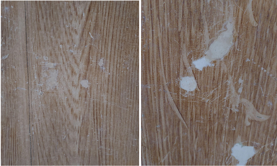
Pilt 28. Vasakul toonitud alustooniga augud. Paremal pooleldi krunditud auk ja kruntimata augud
