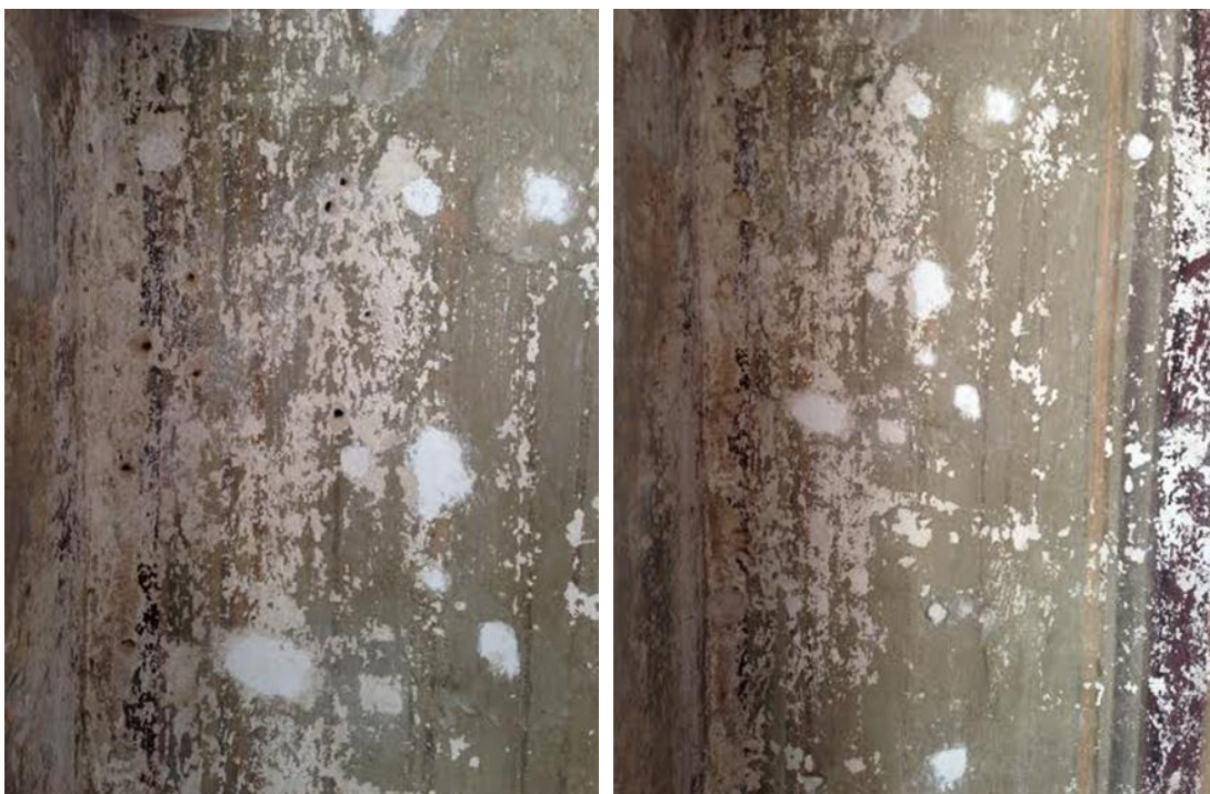
Foto 6-7 Fragment maalingust enne ja peale krohvi- ja pahtliparandusi
