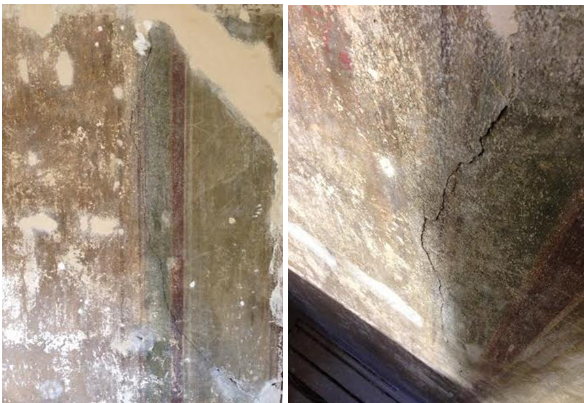
Foto 2-3 Hiljem kruvidega kinnitatud pragu enne parandusi
