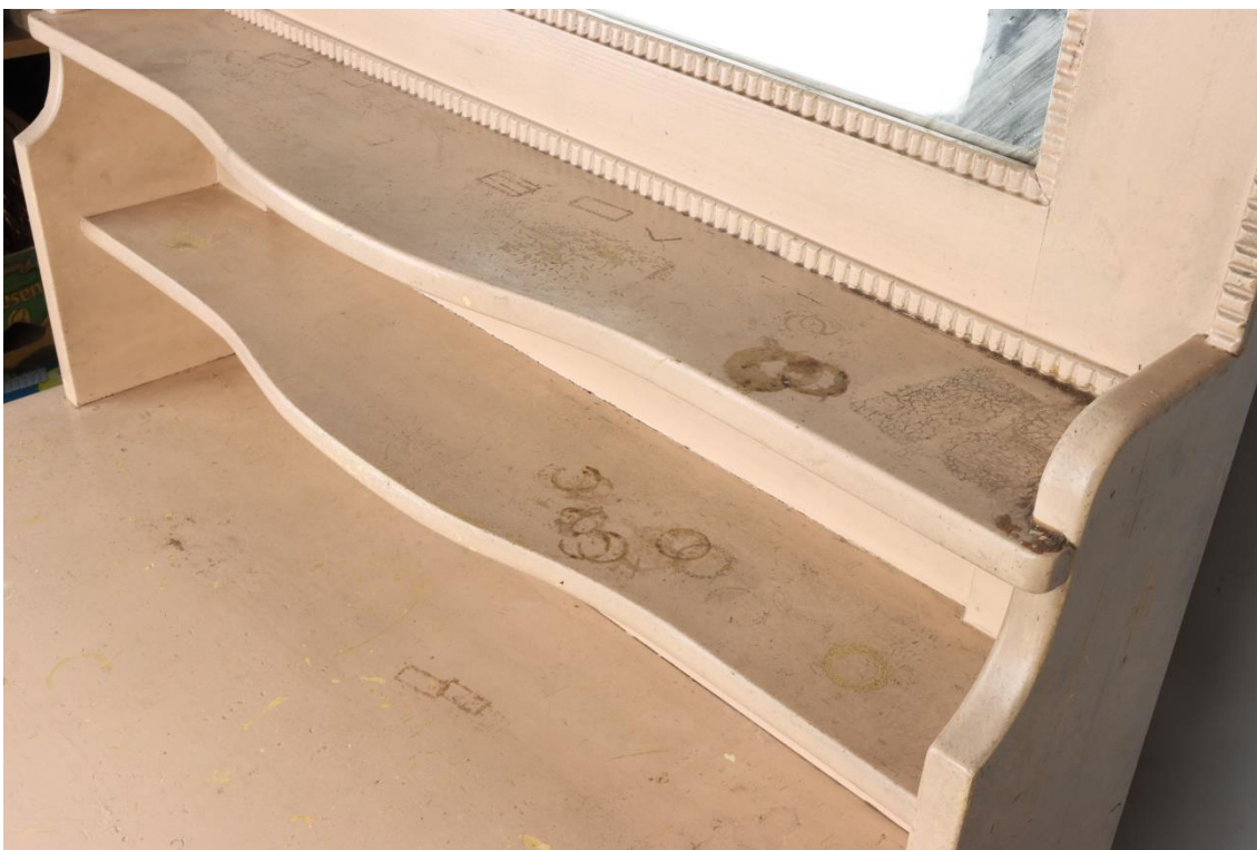
Foto 4. Viimistluse kahjustused pesulaual
