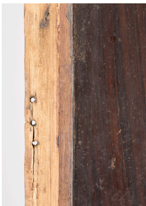
Foto 5. Tapi tugevdamiseks täiendavalt lisatud tüübel.
