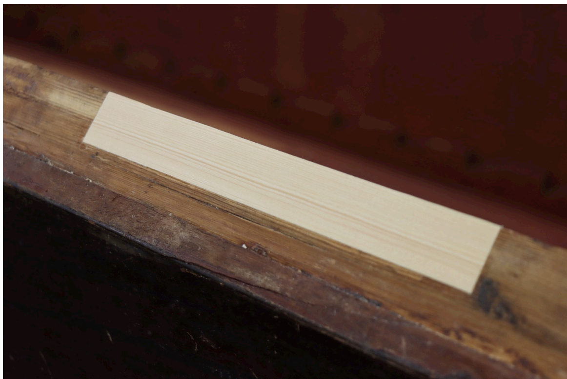
Foto 15. Hingede lõhenenud kinnituspinna parandus.
