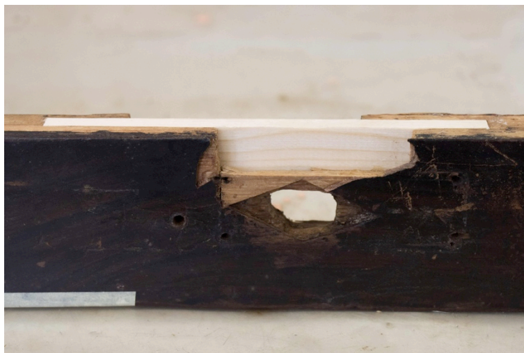
Foto 16. Ukse raampuu puiduparandus.
