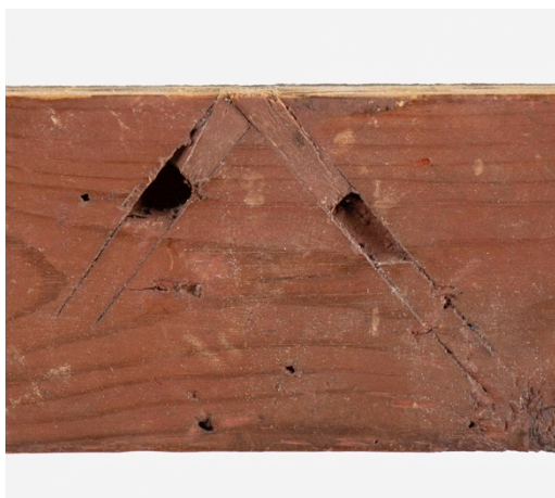
Foto 8. Prosspulkade jäljend ukse vahepuus.
