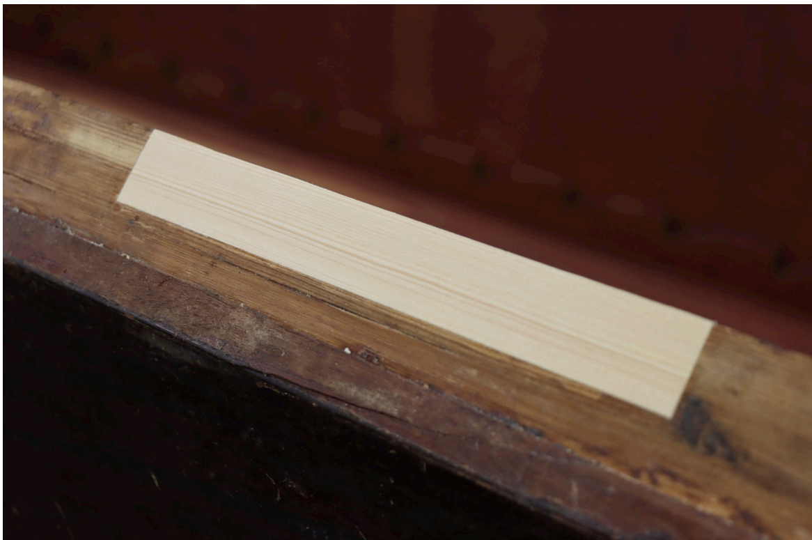
Foto 15. Hingede lõhenenud kinnituspinna parandus.
