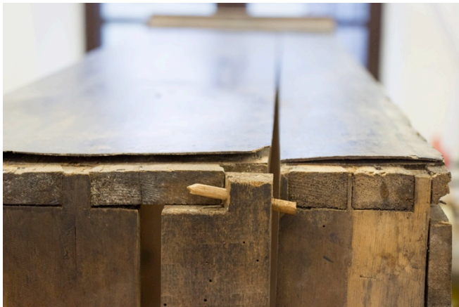
Foto 5. Tapi tugevdamiseks täiendavalt lisatud tüübel.
