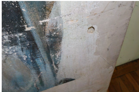
Joonis 2.20. Põhjapoolse seina kulumise jäljed ja krohvimist vajav auk. Foto: Randel Saveli
