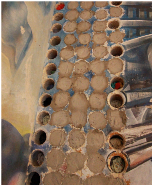
Joonis 2.27. Püstitorude avad, mis on sooja hoidmiseks täidetud tsemendiseguga. Kaltsudega täidetud augud on ilmselt täidetud selleks, et suvel temperatuuri "reguleerida". Foto: Randel Saveli
