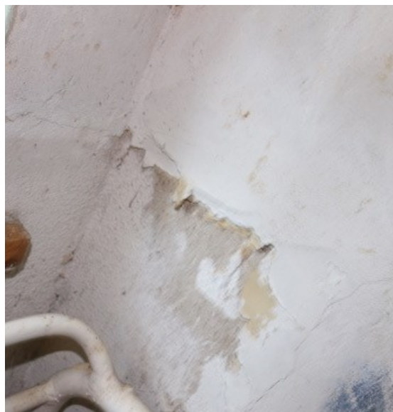
Joonis 2.13. Niiskuskahjustused maalingu aknapoolses küljes. Foto: Randel Saveli
