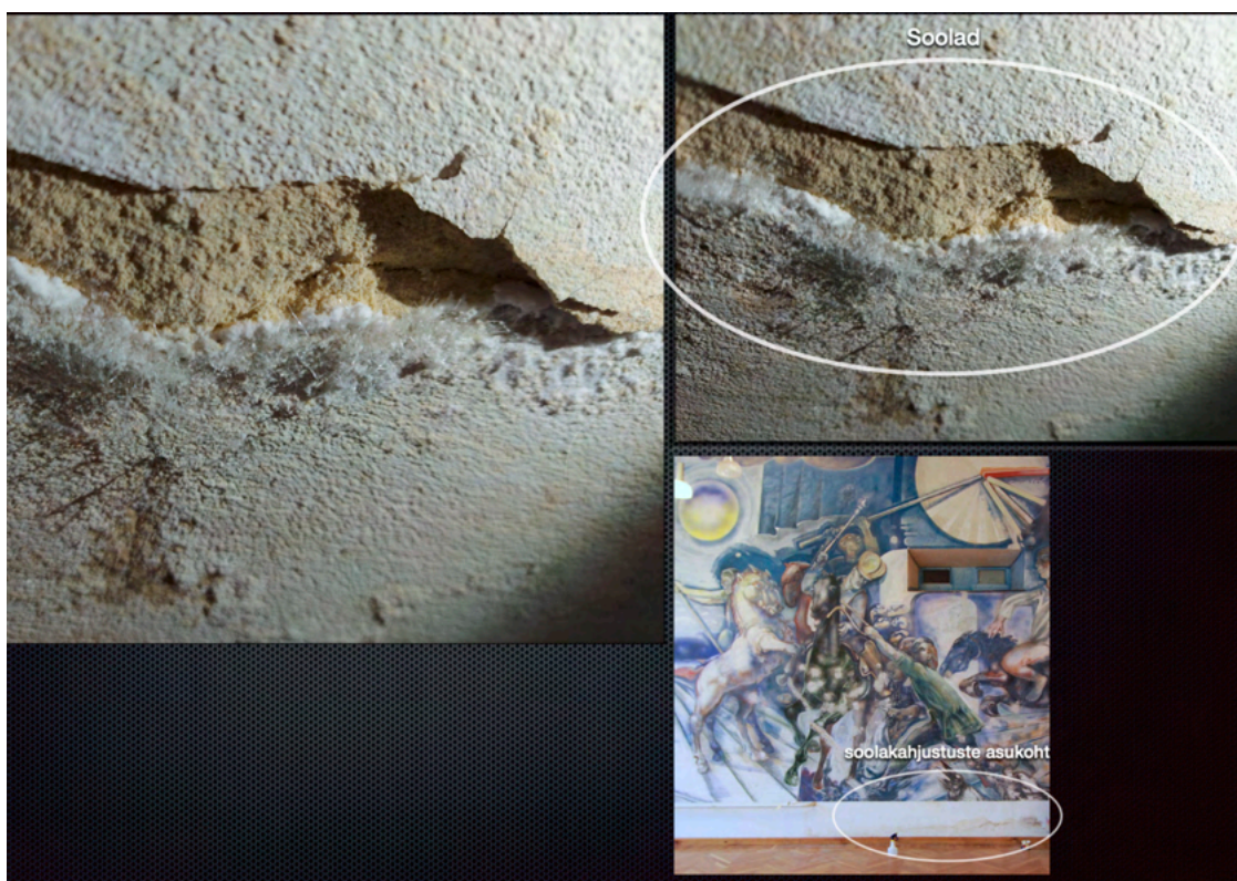
Joonis 2.16. Soolakahjustused ja nende asukoht maalingul. Foto: Randel Saveli
