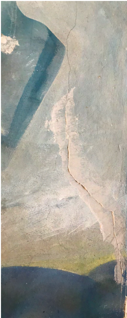
Joonis 2.17. Üks suuremaid pragusid maalingul, mis läbib tervet seina maast alt üles. Foto: Randel Saveli
