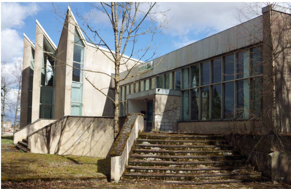
Joonis 1.28 Põdrangu keskusehoone fassaad tänapäeval. Hetke kurbseis on see, et puud kasvavad läbi hoone vundamenti. Foto: Randel Saveli
