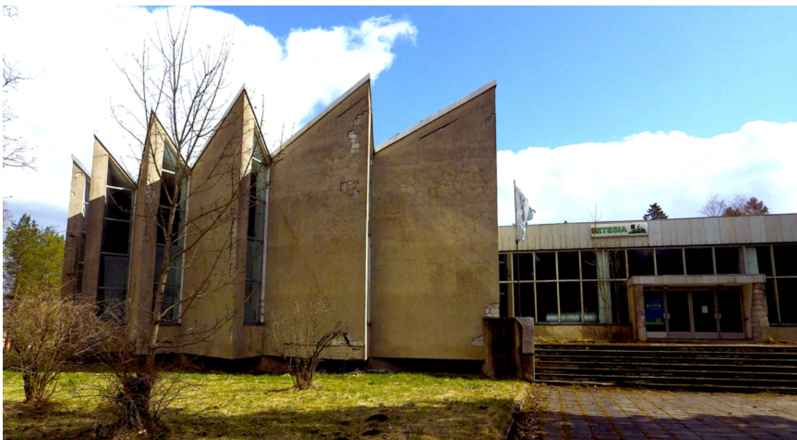
Joonis 1.29 Põdrangu fassaad 2021. aastal.
