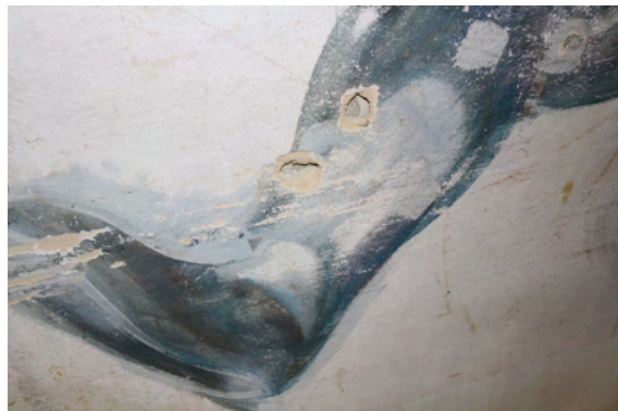
Joonis 2.19. Krohvimist vajavad kahjustused. Foto: Randel Saveli
