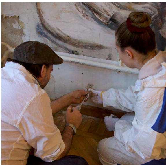
Joonis 2.14. Probleemse koha injekeerimine Ledaniga. Antud piirkonnas oli oht, et suur osa krohvi eemaldub seinast koos maalinginguga. Ledan aitas edukalt kinnitada seda osa seinast. Foto: Janne Randma
