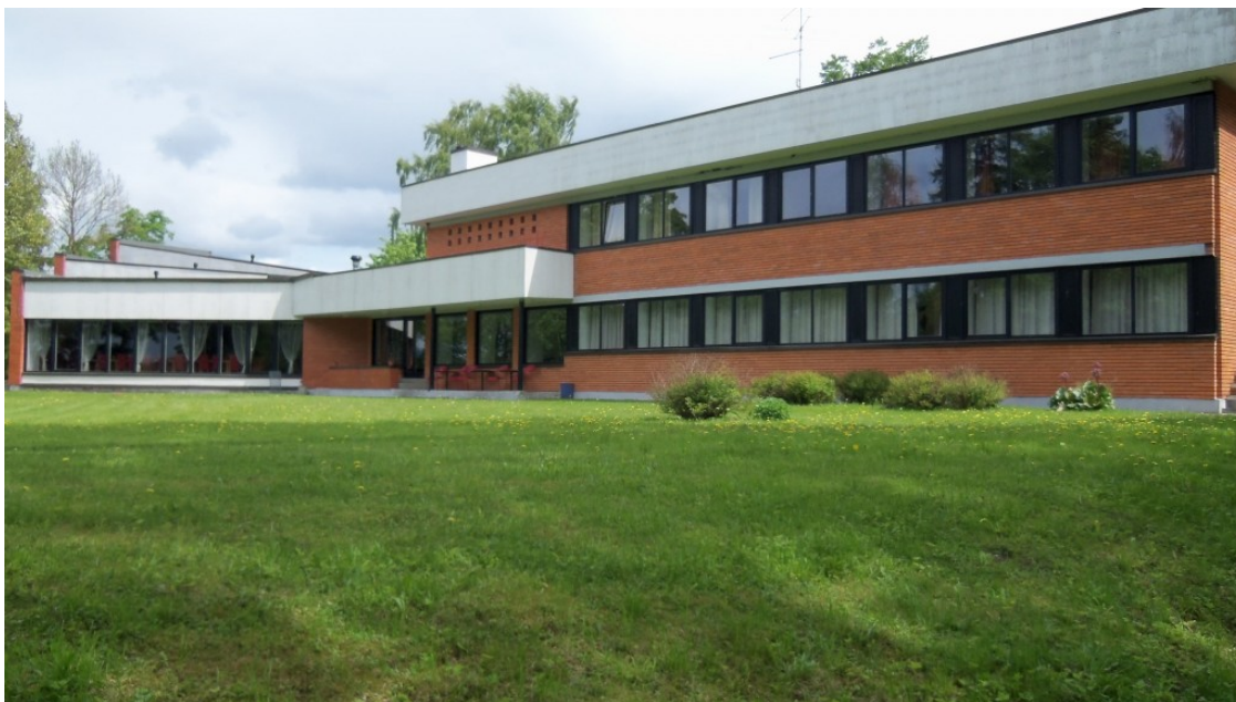
Joonis 1.16. Kurtna katsejaama hoone. Näide põhjamaade modernismist mida nimetatakse ka "karniisiarhitektuuriks". Arhitekt V. Pormesiter.
