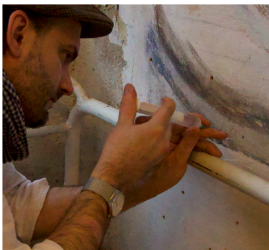
Joonis 2.10. Süstlaga piirituse süstimine õõnsustesse, mis aitab Ledani paremini pinnaga siduda. Foto: Janne Randma
