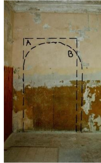
Pilt 9 Vaade ballisaalist. (A-ehitusjärgne ukseava; B-19.sajandi esimesel poolel loodud avaus) Avaus müüriti kinni 20.sajandi teisel poolel (Dirveiks et al 2021)
