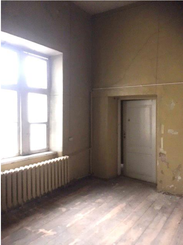
Foto 5. Vaade põhjanurka, põrandal vana laud.
