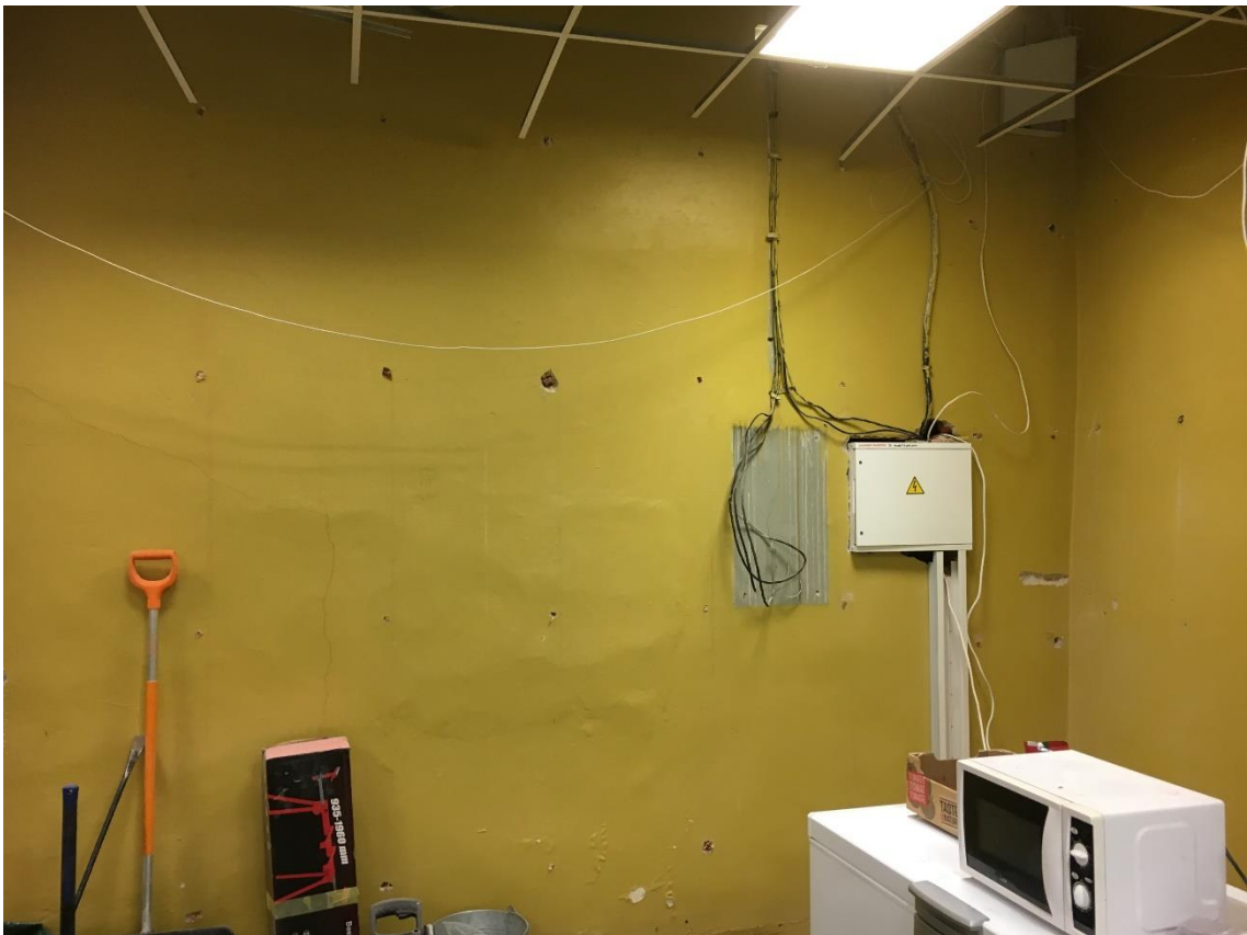
Foto 14. Vaade lõunanurka, kaguseinas suur paranduskoht.
