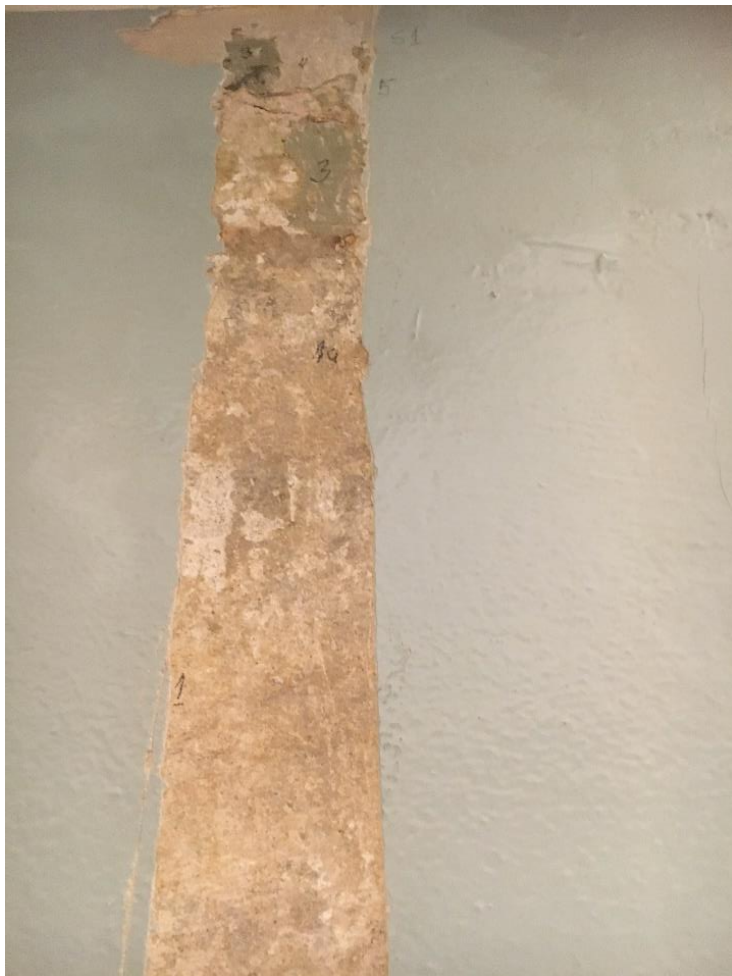
Foto 2. Seina ülemise serva sondaaž.
