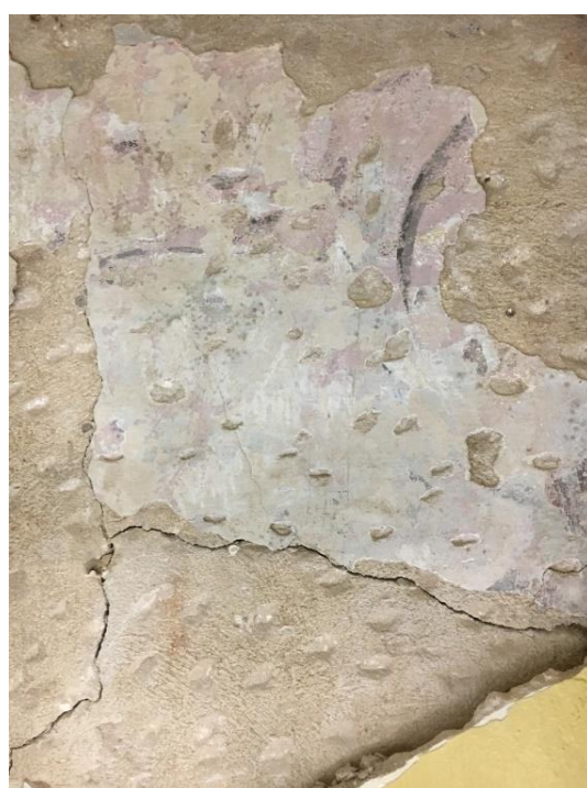
Foto 4. Krohvaluse kihistuse fragmendid.
