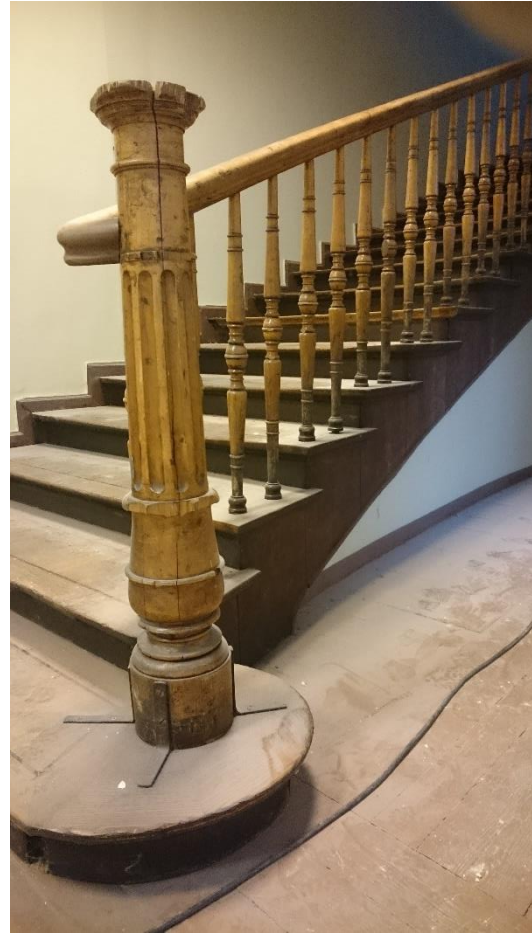
Foto 2. Trepp ja -post I korrusel.
