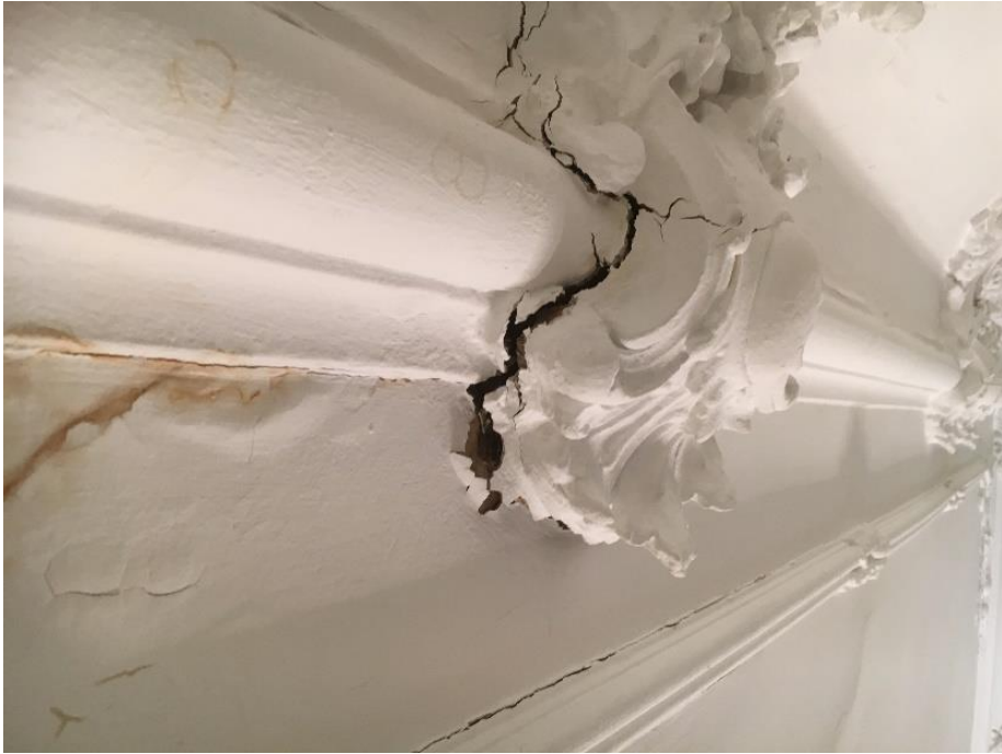
Foto 4: Kahjustused loodepoolses seinas peegelvõlvil.
