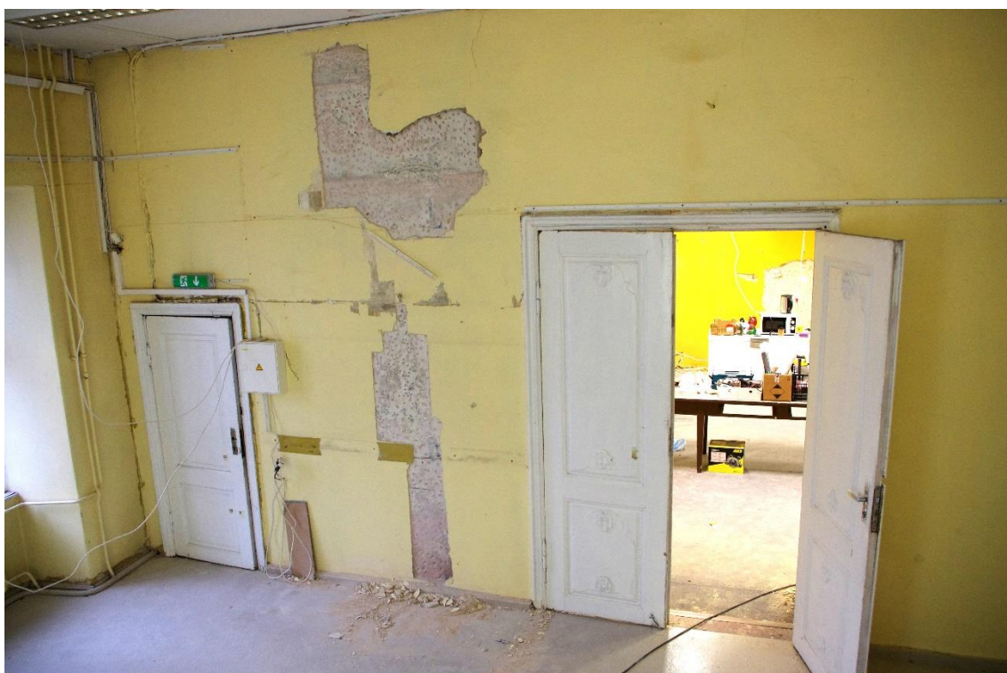
Foto 2. Suur seinasondaž edelaseinas.
