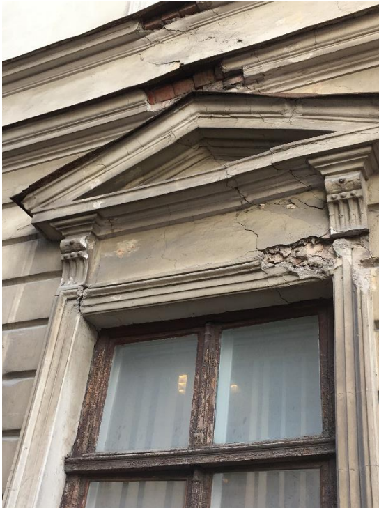
Foto 2. I korruse akna kohal olev kolmnurkfrontoon, vajumisest tingitud kahjustused.
