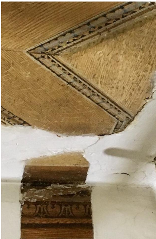
Foto 6. Sondaažid seinas ja laes.
