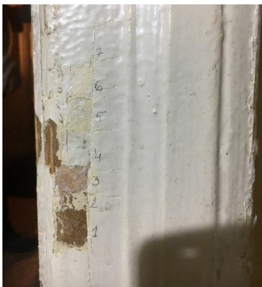
Foto 1. Ukse U23 piirdeliistu sondaaž.
